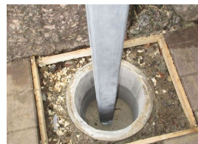
Köcherfundament zum Einspannen der Stahlstützen
